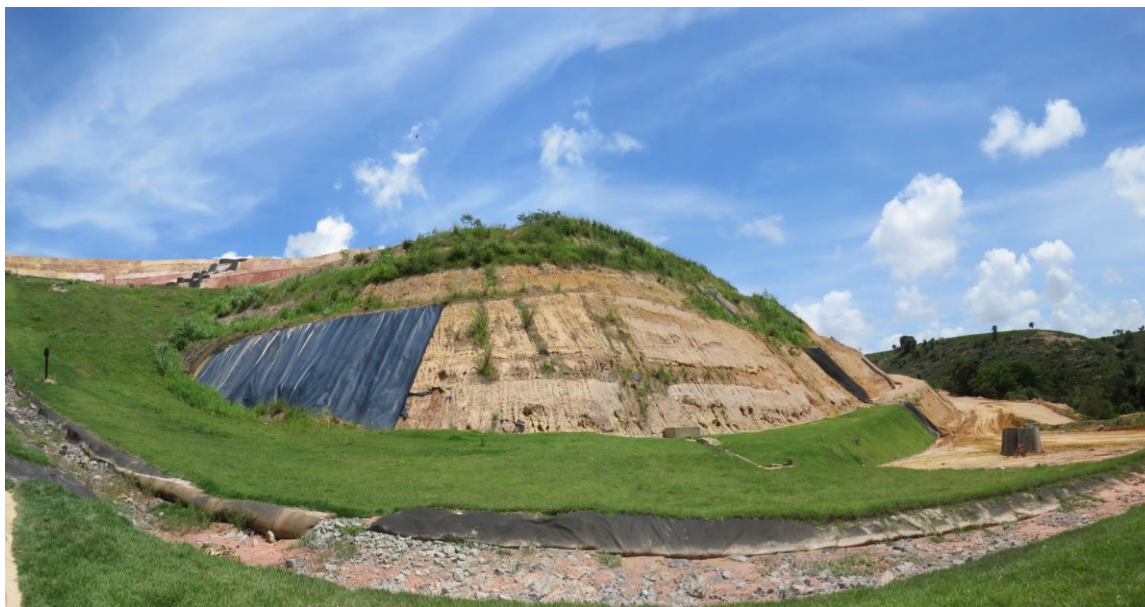
FIGURA 45. Talude Erodido
