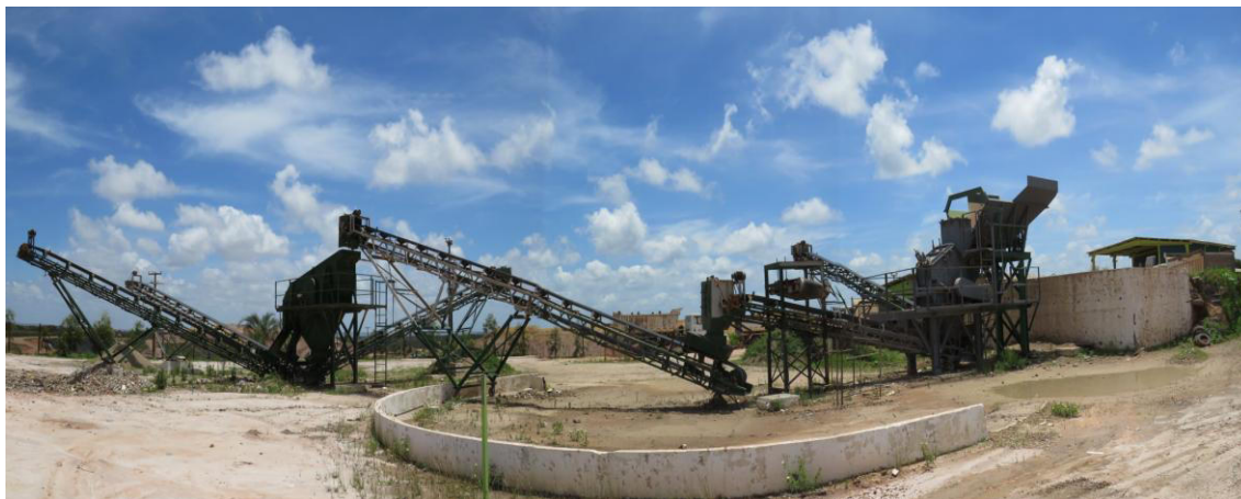
FIGURA 46. Estação de Beneficiamento de Entulhos
