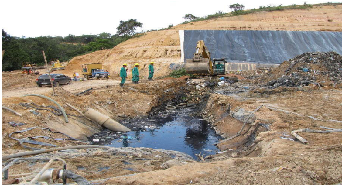
FIGURA 17. Colocação de elemento drenante
