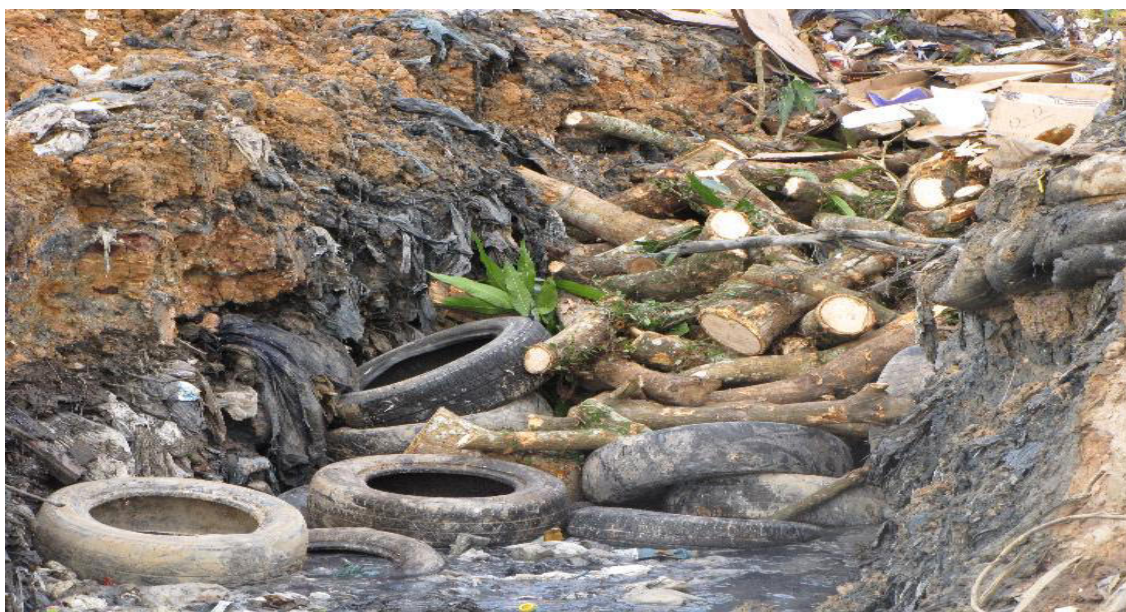
FIGURA 17. Colocação de elemento drenante
