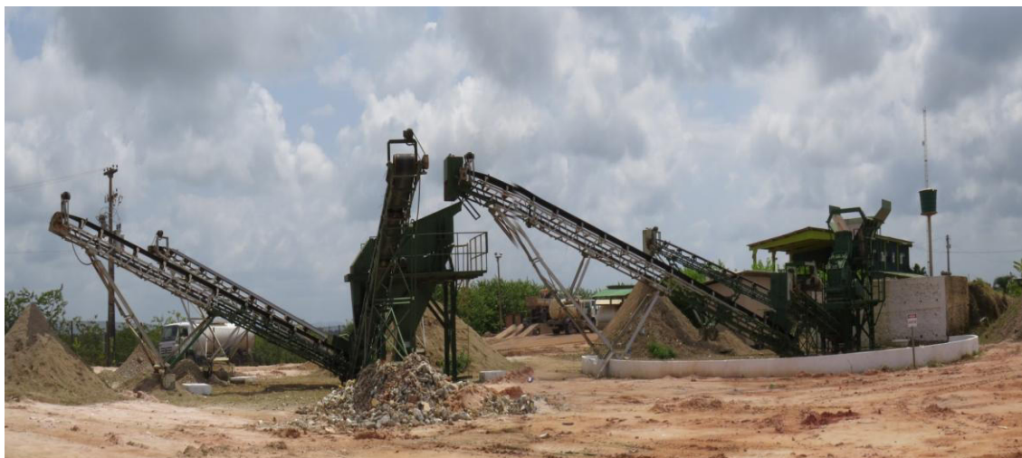
FIGURA 32. Estação de beneficiamento de entulhos
