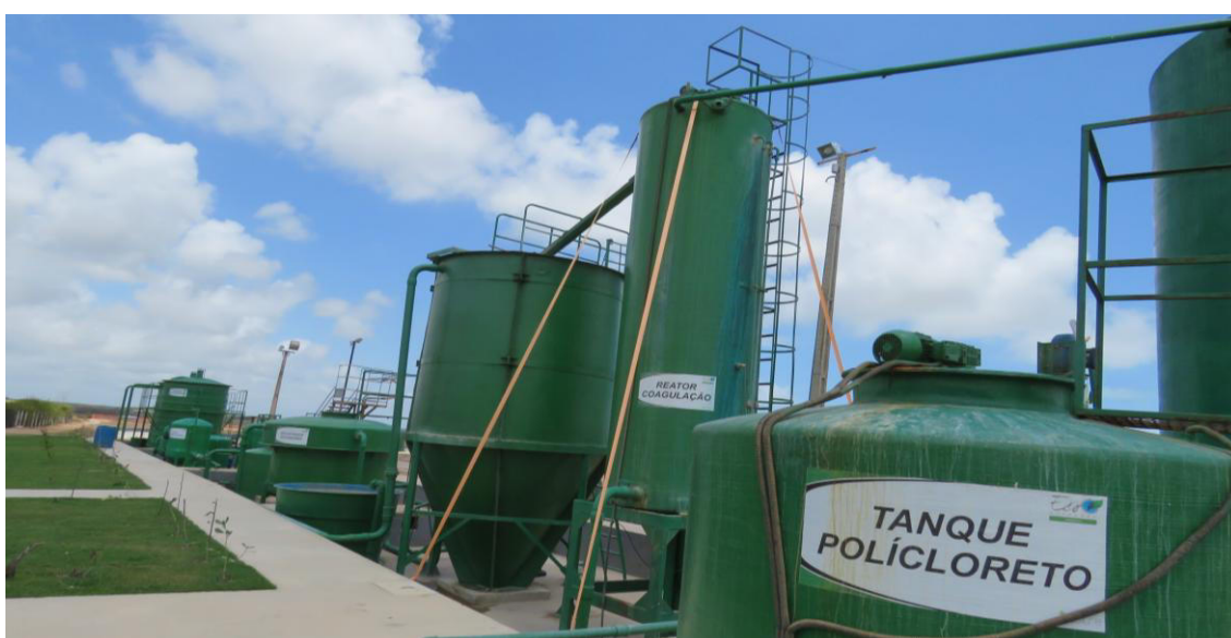
FIGURA 61. Estação de Tratamento de Percolado
