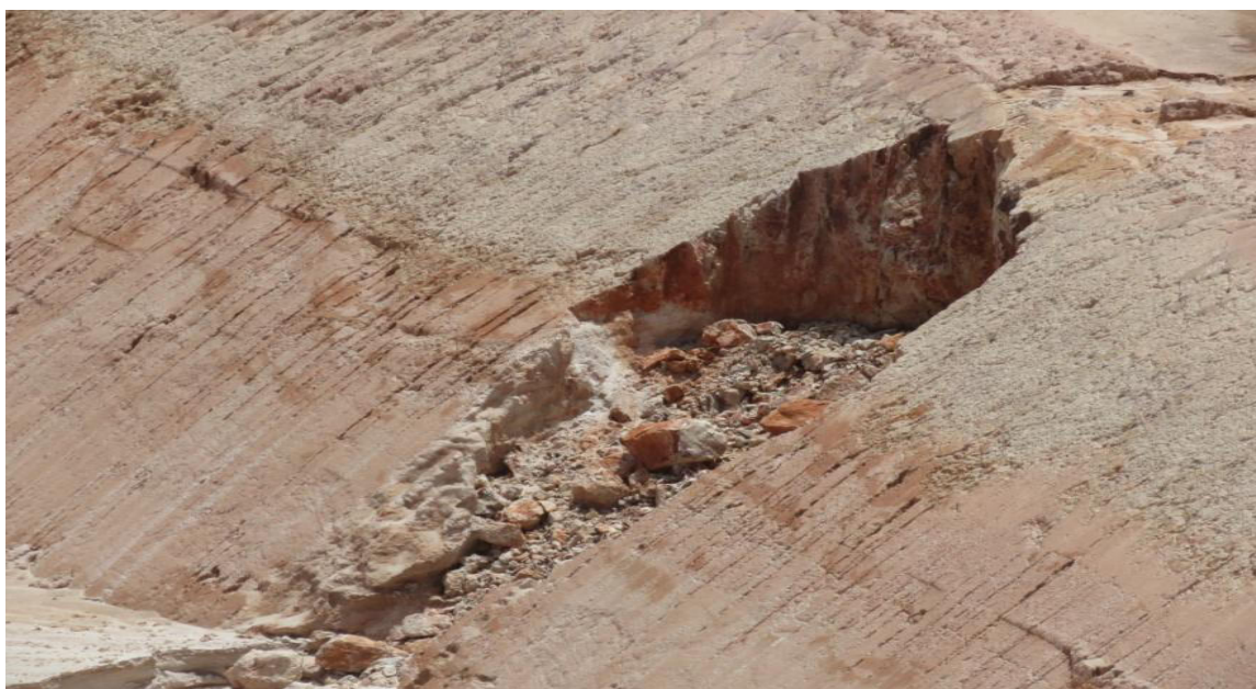
FIGURA 45. Talude Erodido
