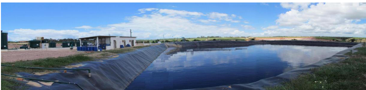
FIGURA 24. Lagoa de distribuição e segurança
