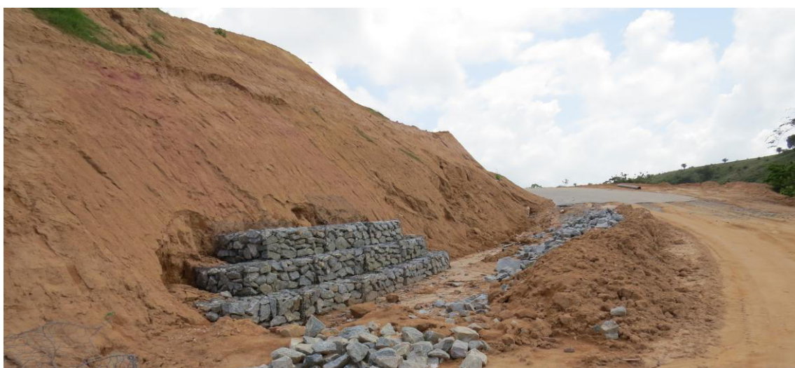
FIGURA 31. Construção de gabião
