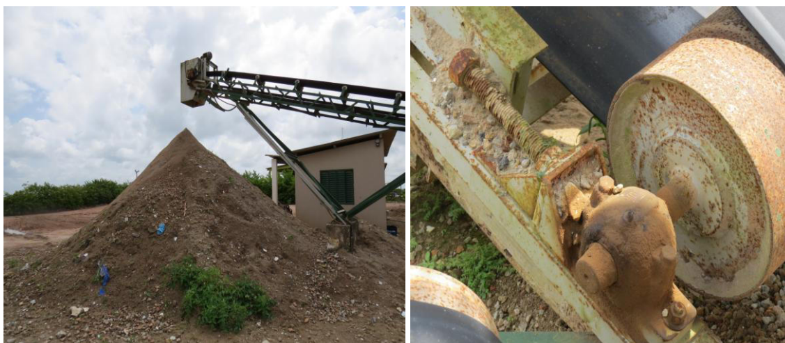
FIGURA 33. Estação de beneficiamento de entulhos
