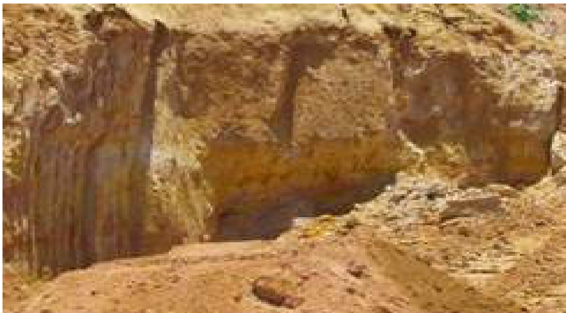
FIGURA 23. Talude erodido
