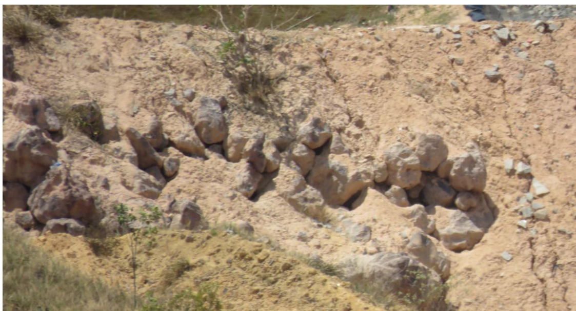
FIGURA 57. Talude Erodido
