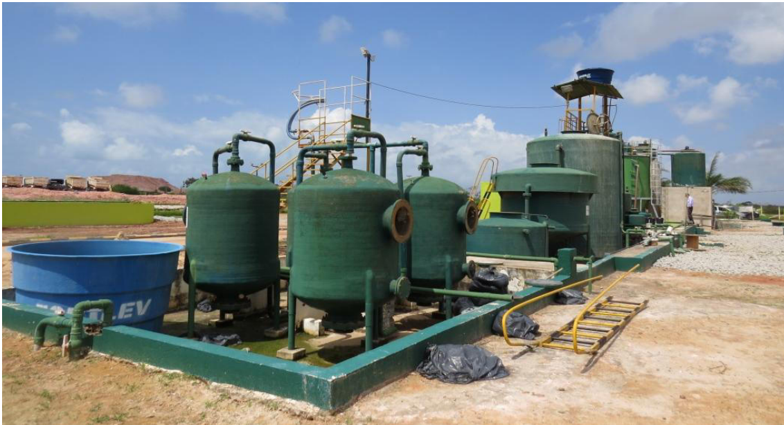
FIGURA 37. Estação de tratamento de percolado
