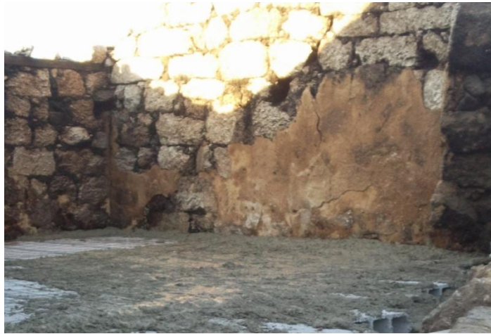
Imagem 16: Betonagem da Laje de Piso
