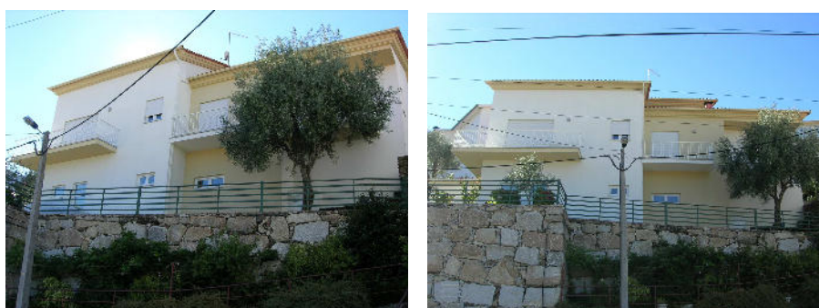
Figura 49 – Moradia unifamiliar no Bairro do Carrascal - Manteigas Autor dos projetos de arquitetura, especialidades e fiscalização - 04/2005
