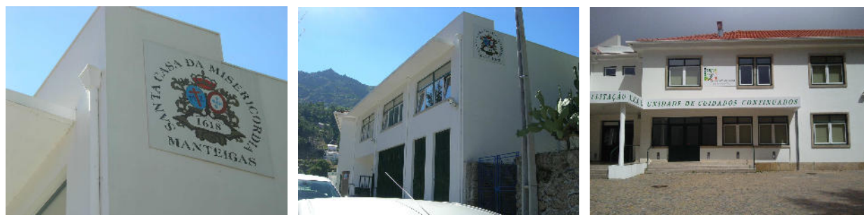
Figura 12 – Vistas gerais da zona ampliada da obra de cuidados continuados, concluída
