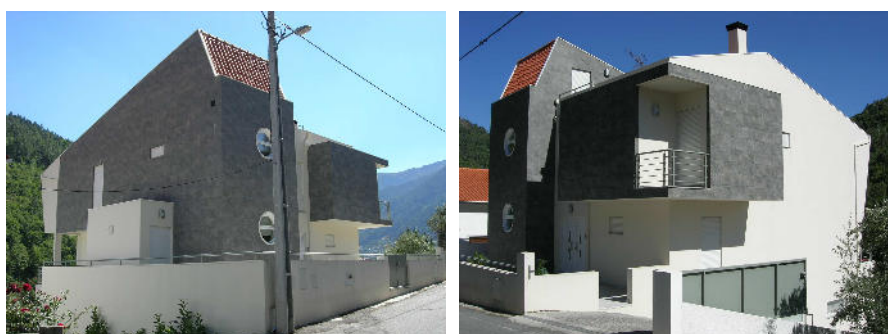
Figura 61 – Moradia unifamiliar no Palmeiro – Manteigas Autor dos projetos de especialidades e fiscalização – 03/2009
