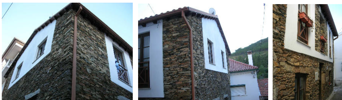
Figura 48 – Alojamento local em Sabugueiro - Manteigas Alteração e ampliação de habitação / alojamento local Autor dos projetos de especialidades e fiscalização - 02/2005
