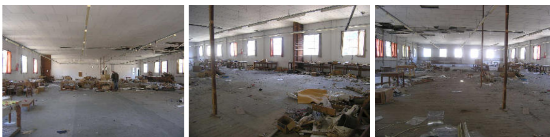
Figura 19 – Interior da antiga fábrica “SOTAVE” - antes da intervenção
