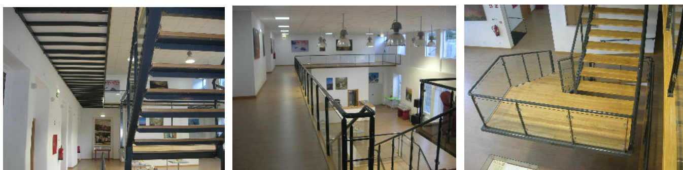
Figura 39 – Escadaria e passadiço em estrutura metálica, obra concluída – “Ninho de empresas
