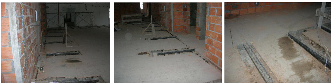
Figura 35 – Perfis tubulares encastrados na laje, durante a obra – “Ninho de empresas”
