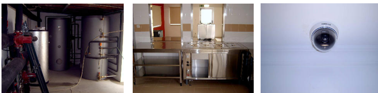
Figura 16 –Equipamentos da obra de cuidados continuados - Conclusão
