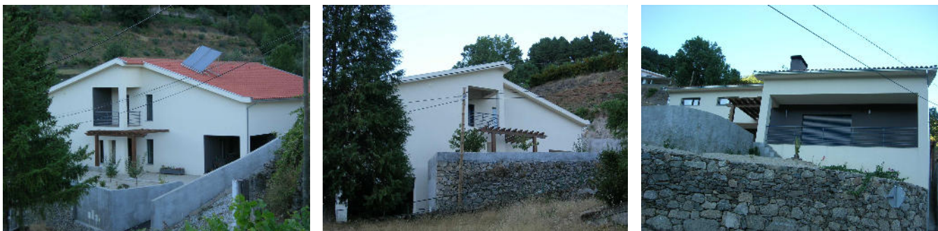
Figura 65 – Moradia unifamiliar no Sítio da Granja – Manteigas Autor dos projetos de especialidades – 09/2010
