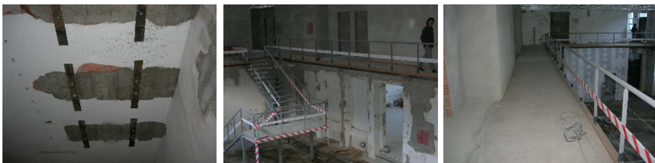
Figura 36 – Amarração dos perfis à laje e passadiço, durante a obra – “Ninho de empresas”
