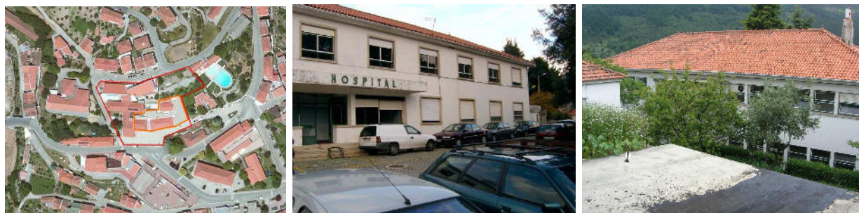
Figura 3 – Localização e vistas exteriores do imóvel (antigo hospital) - antes da intervenção
