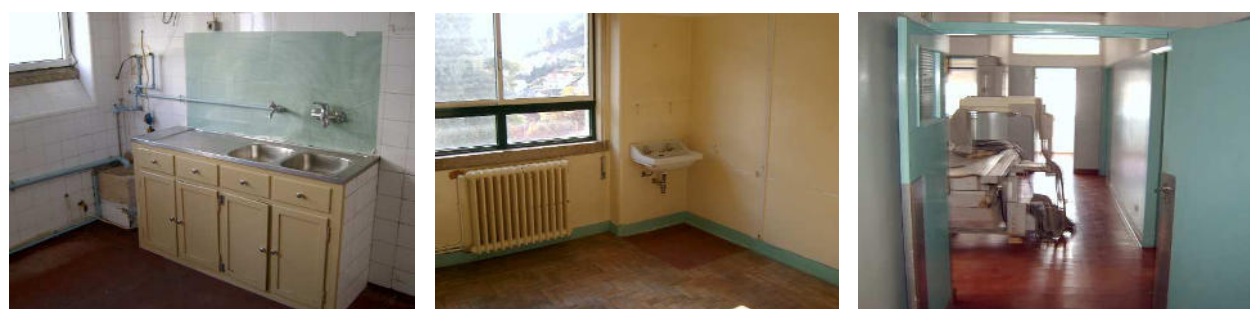
Figura 6 – Enfermaria, Quarto de doente e TAC - antes da intervenção - (antigo hospital)
