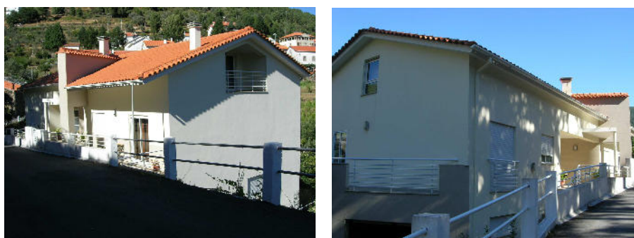
Figura 51 – Moradia unifamiliar na Regada - Manteigas Autor dos projetos de arquitetura, especialidades e fiscalização– 08/2005
