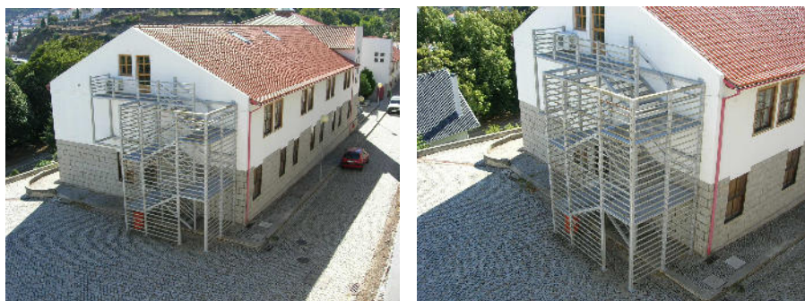
Figura 53 – Escola de Hotelaria de Manteigas Alteração e ampliação de Escola de Hotelaria de Manteigas Autor dos projetos de arquitetura, especialidades e fiscalização de escadaria metálica – 02/2006
