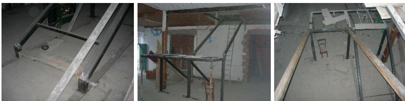
Figura 34 – Vistas da estrutura da escada metálica, durante a obra – “Ninho de empresas”
