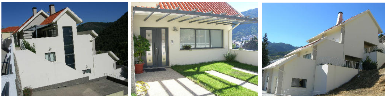
Figura 59 – Moradia unifamiliar no Loteamento Senhora de Fátima - Manteigas Direção de Fiscalização técnica de obra – 01/2009
