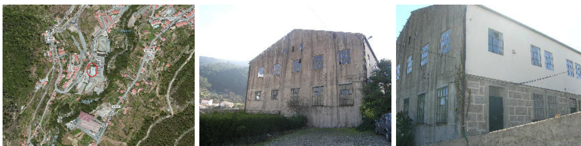
Figura 18 – Localização e vistas exteriores da antiga fábrica “SOTAVE” - antes da intervenção
