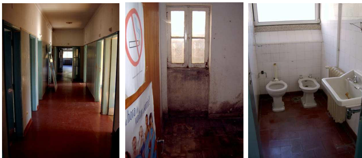
Figura 5 – Circulação, Sala de atendimento e Instalações Sanitárias - antes da intervenção - (antigo hospital)
