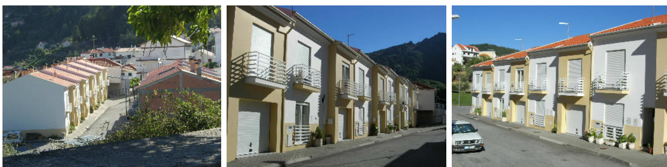
Figura 46 – Moradias unifamiliares em banda no Loteamento Santa Maria - Manteigas Autor dos projetos de arquitetura, especialidades e fiscalização – 2004 / 2014
