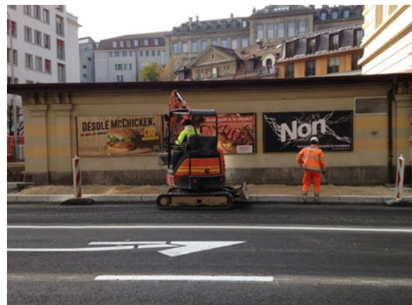
fig19. Ouvriers travaillant sur la chaussée
