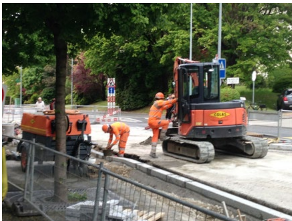
fig34. Ouvriers en action
