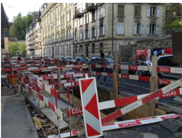
fig20. Vue du chantier depuis la rue César-Roux 25
