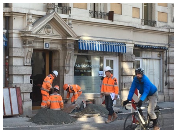
fig21. Ouverture de fouille devant l'accès d'un immeuble
