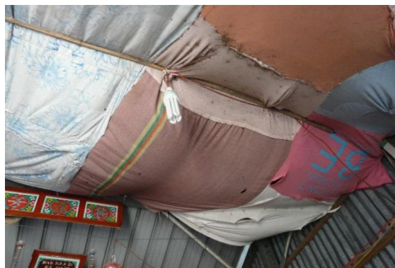
Figure 24 : Draps sous la toiture pour protéger de la chaleur, maison à An Giang n°12
