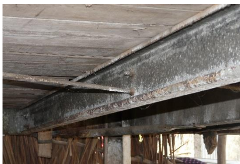
Figure 76 : Tiges de contreventement
