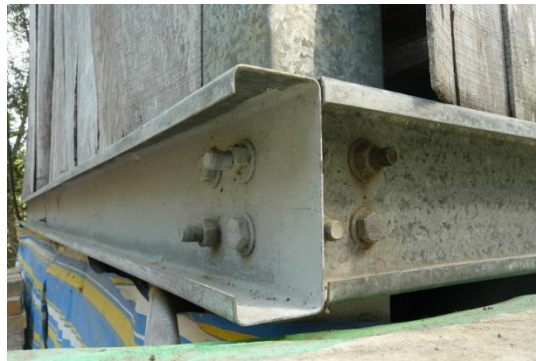
Figure 103 : Connexion colonne – poutre principale/secondaire de bord
