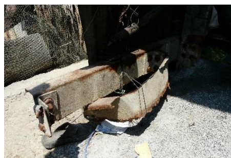
Figure 15 : Poutre secondaire cassée, maison à Kien Giang n° 12
