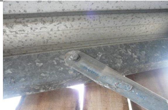
Figure 53 : Connexion barres de contreventement (1 boulon)
