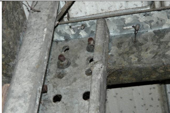
Figure 52 : Connexion colonne – poutre en Z (2 boulons)
