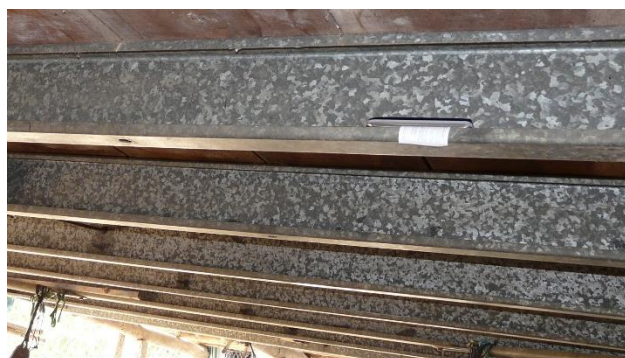
Figure 28 : Poutres inférieures en bon état, maison d'An Giang n°4
