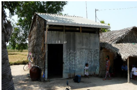
Figure 10 : Maison à Kien Giang n° 19 (Phu My)
