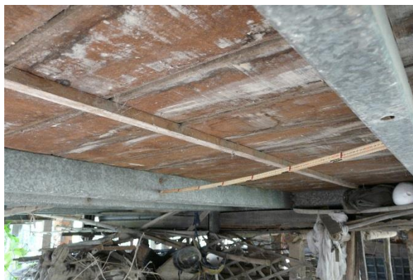
Figure 36 : Retrait d'une poutre, Espacement entre les 2 poutres environ 120 cm ; maison à An Giang n°16
