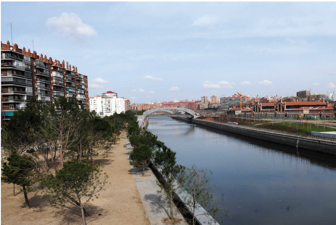
Δίδυμες γέφυρες Puentes Cascara Cascara Twin Bridges
