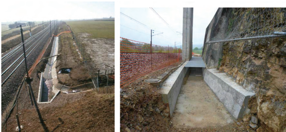
Figure 4 : Photos de travaux de régénération aux abords des voies LGV.
