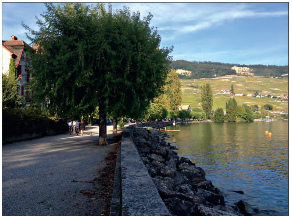
Figure 5. Photo d'une rive-type le long du lac (à Cully VD), la rive est réduite à un mur précédé d'enrochements (photo: Giovanni De Cesare). Abbildung 5. Foto einer typischen Küste am See entlang (in Cully VD), das Ufer reduziert sich zu einer Mauer, geschützt durch ein Blockwurf (Foto: Giovanni De Cesare).
