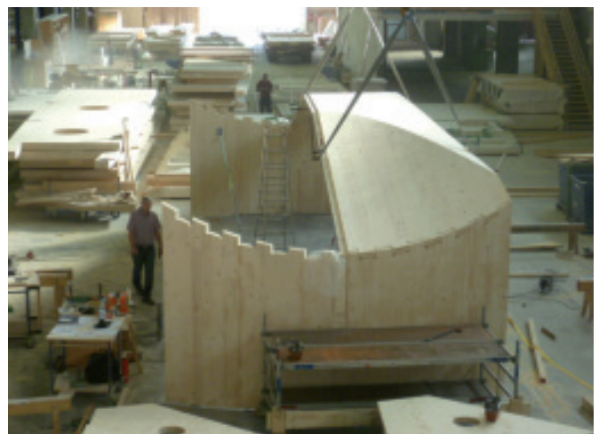
Bild 6. Fügung der gezinkten Bauteile aus Brettsperrholz Fig. 6. Assembly of the dovetail-jointed CLT components
