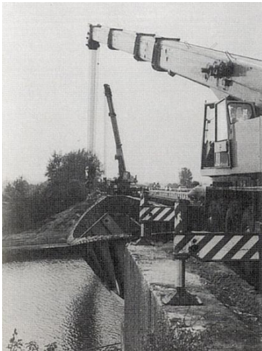
b) pont sur le canal Mitelland près de Dedensen, Allemagne, 1982
