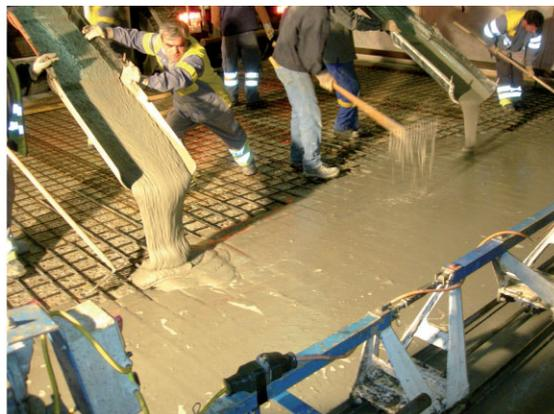
**Bild 11** Querschnitt über Auflager der mit bewehrtem Stahl-UHFB verstärkten Rippendecke und Einbringen des Frisch-UHFB
