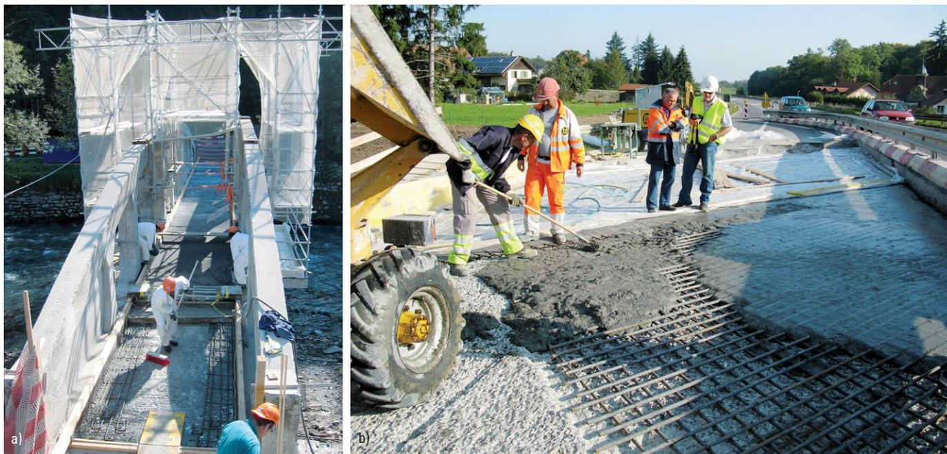
**Bild 12** Trag- und Schutzfunktion durch Stahl-UHPFB: a) Fahrbahnplatte als Zuggurt einer Bogenbrücke, b) Biege- und Schub-Verstärkung über Stützen einer massiven Platte
