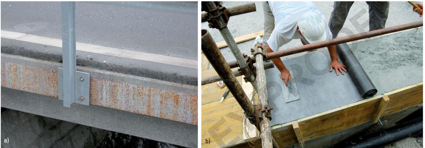
**Bild 9** a) Rostpunkte auf einer in einer Stahlschalung hergestellten UHPFB Oberfläche, b) Bearbeitung der Oberflächen mit profilierter Folie [27]
