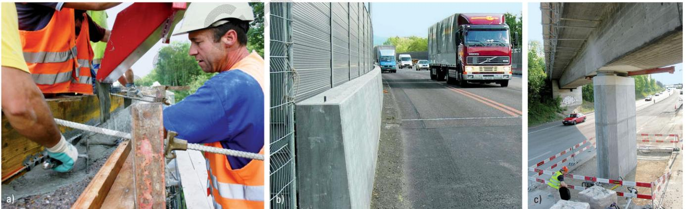
**Bild 10** a) Einbringen des Frisch-UHPFB, b) Ansicht der Leitmauer mit UHPFB Beschichtung, c) UHPFB-Fertigteile ummanteln einen Brückenpfeiler
