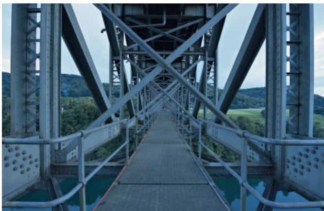
Bild 2. Inspektiongang auf der unteren Ebene des Stahlfachwerkes
