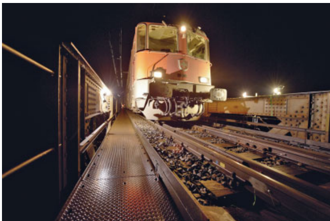
Bild 7. Lokomotivzug auf Lastposition 10 während der Belastungsversuche
