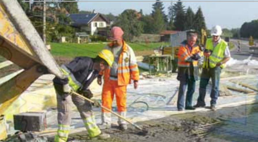
Verstärkung und Instandsetzung einer Straßenbrücke bei Lausanne mit UHFB.
