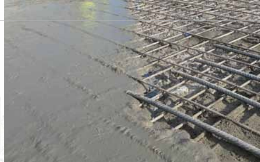
Stahl-UHFB ist die Kombination von UHFB mit Stab- oder Vorspannbewehrung in der Haupttragrichtung.
