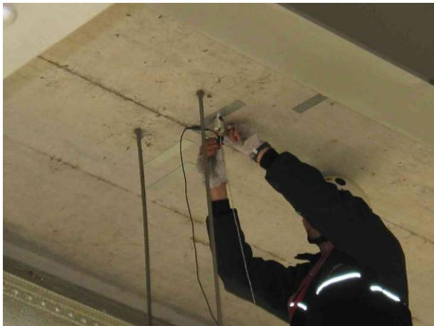
Bild 6 : Anbringen eines Reibungsmessstreifens an der Unterseite der Betonplatte
