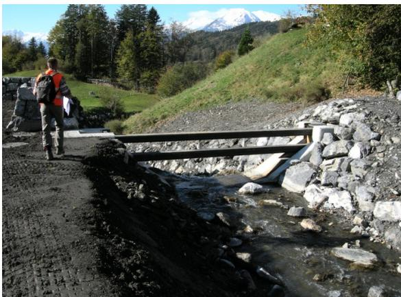
**Fig. 17** Détail de l'aménagement d'une grille-seuil
