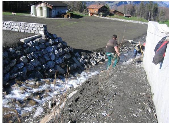
**Fig. 18** Rampe en blocs entre les terrasses 2 et 3
