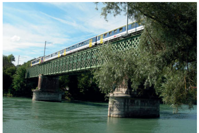
Bild 6. Die seit 1859 in Betrieb stehende Bahnbrücke über den Rhein zwischen Koblenz (CH) und Waldshut (D) genügt auch den Anforderungen des künftigen Bahnverkehrs [9]. Nach der Ausführung von geringfügigen baulichen Erhaltungsmaßnahmen wird das Bauwerk wieder ein junges äquivalentes Alter aufweisen.
