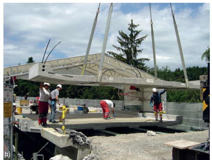
Bild 8. Schwarzwasserbrücke südlich von Bern: a) Ansicht, b) Einbau der neuen Fahrbahnplattenelemente Fig. 8. Schwarzwasser Bridge south of Bern: a) side view, b) construction of the new deck slab elements
