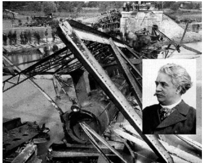
Bild 1. Einsturz der Bahnbrücke über die Birs bei Münchenstein bei Basel am 14. Juni 1891 (Porträtbild von Prof. Ludwig von Tetmajer, einer der Experten zur Klärung der Unfallursache)
