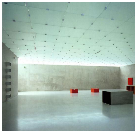
Plafond avec verre diffusant
