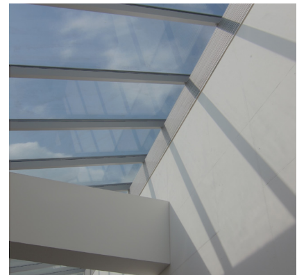
Le système d'éclairage pour le couloir du SG
