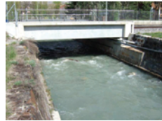
Figure 2, Pont CFF. Vue depuis l'aval
