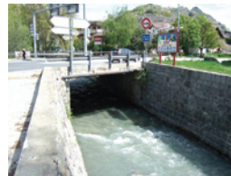
Figure 5, Pont de la Route Cantonale. Vue depuis l'aval
