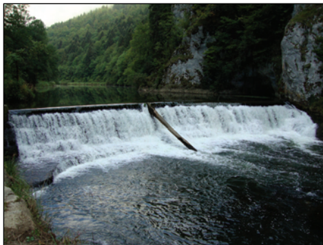
Figure 1.1. Le barrage du Theusseret.
