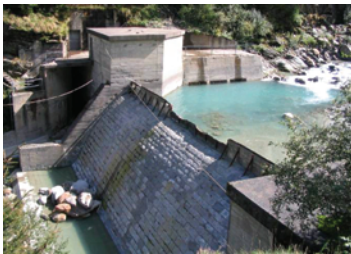
Figure 5: Prise de Lagginbach existante
