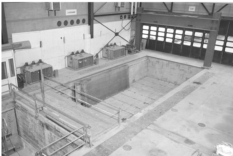
Figure 5.1 : La halle fosse du LAVOC
