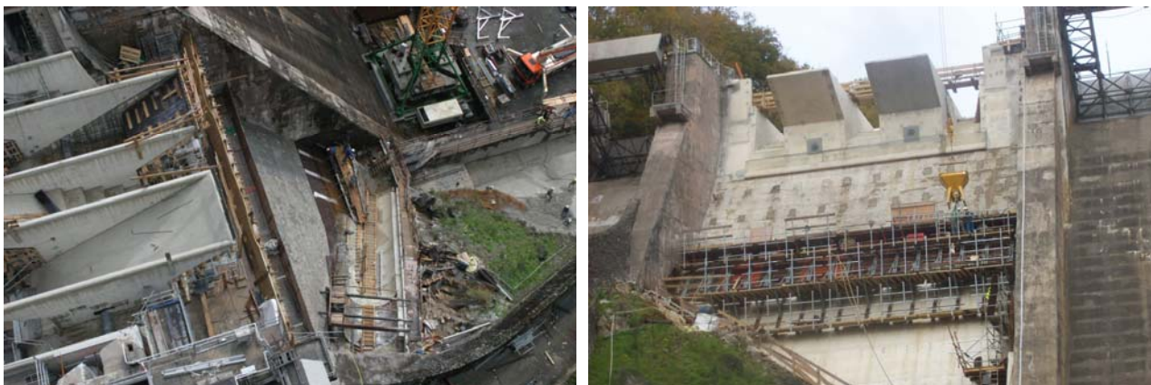
Figure 12: Construction du PK-Weir. Vue de dessus (à gauche) et vue d'aval (à droite)
