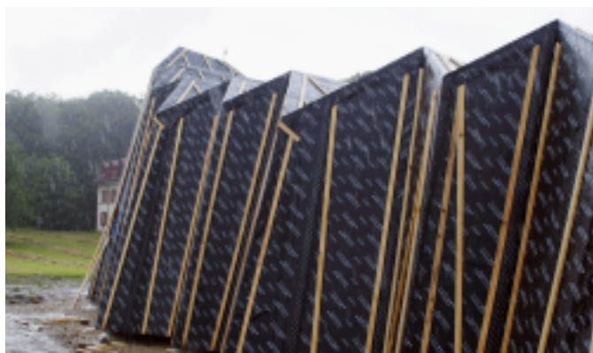
Montage der Wand und Deckenelemente aus Brettspertholz: Unterdachfolie, Lattung, Dreischichtplatten.
