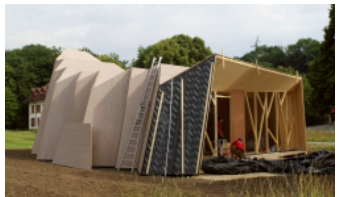
Montage der Wand und Deckenelemente aus Brettspertholz: Unterdachfolie, Lattung, Dreischichtplatten.
