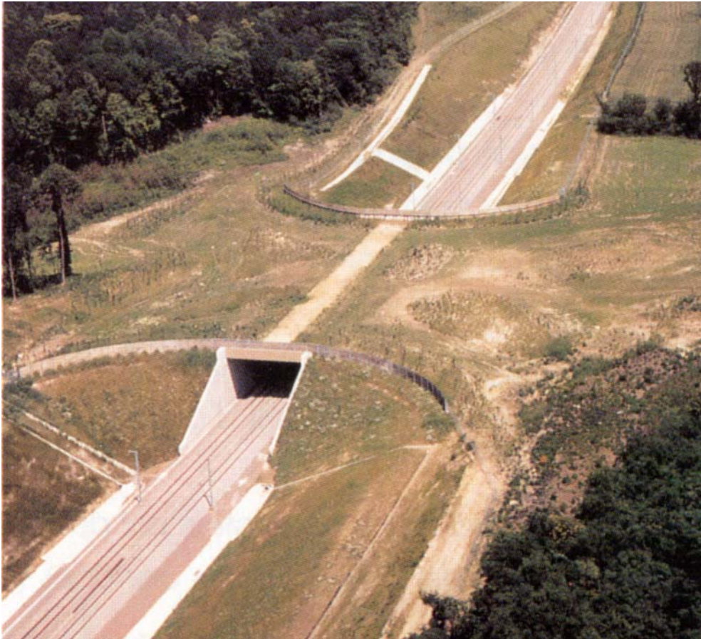
Figure D.6-20 : Exemple de passage supérieur large ou pont biologique
