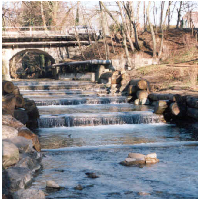
Figures D.6-24 : Exemples d'amélioration d'ouvrages hydrauliques existants (rampes à castor en granit et en bois ; un seuil remplacé par plusieurs)
