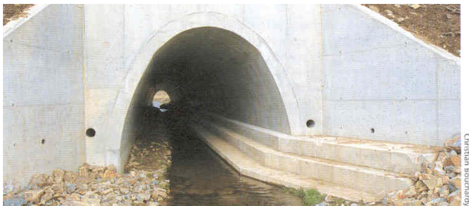
Figures D.6-21 : Passages inférieurs de franchissement d'un cours d'eau
