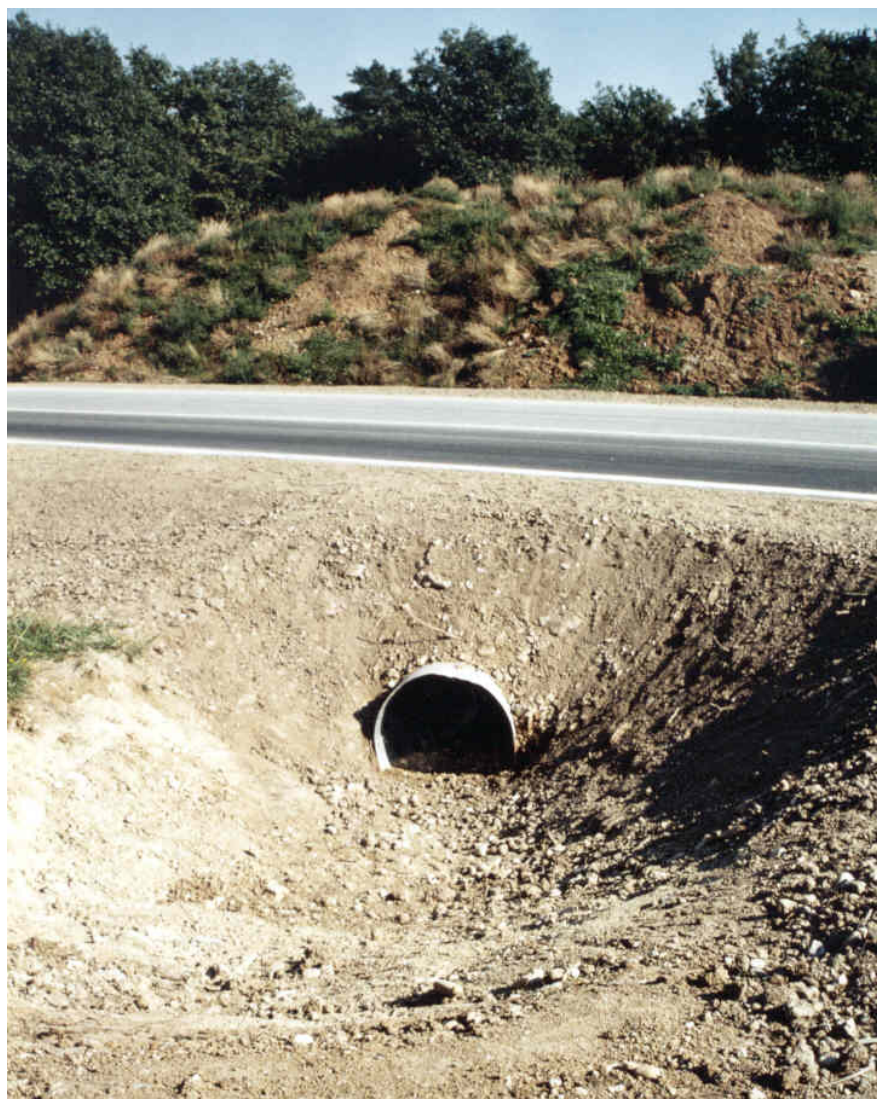
Figure D.6-7 : Exemple de passage simple pour petite et moyenne faune
