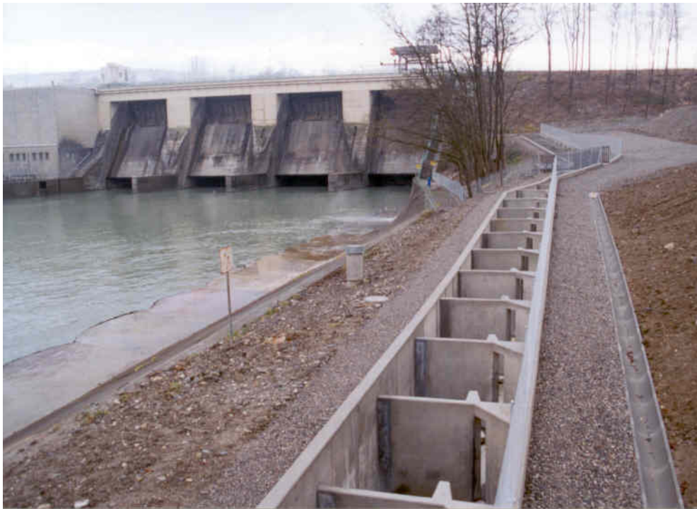
Figure D.6-22 : Exemple de passes à bassins successifs
