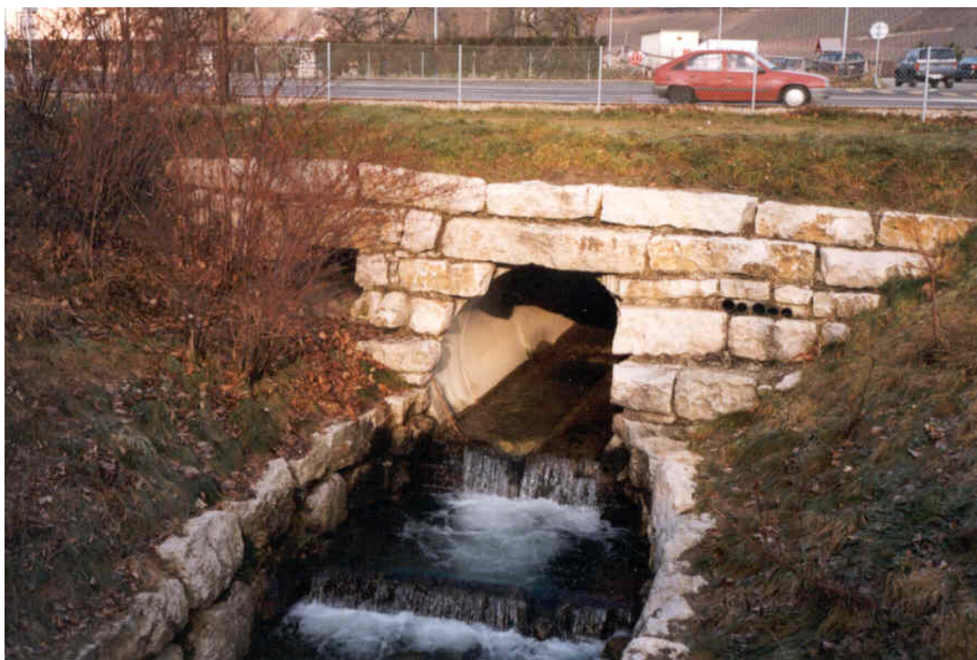
Figure D.6-25 : Voûtage de ruisseau complété par un passage simple pour petite et moyenne faune
