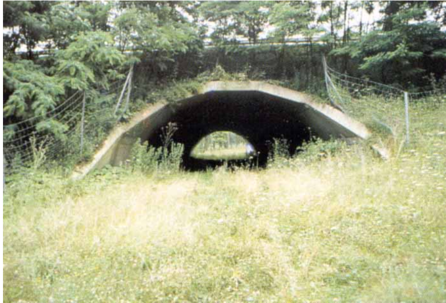
Figure D.6-9 : Exemple de passage inférieur pour faune moyenne
