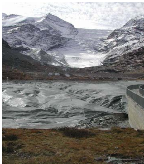
Ensablement du barrage de Tourtemagne
