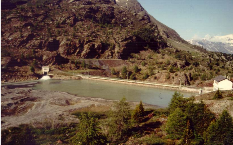
Abbildung 9: Der fast vollständig mit Sedimenten gefüllte Speicher Forni
