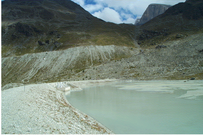
Digue du bassin de décantation avec son déversoir
