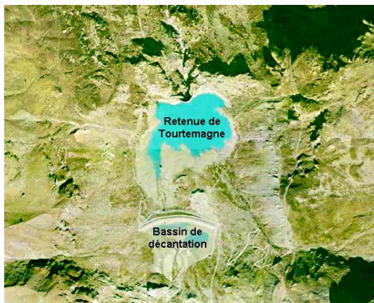
Figure 3: Photo aérienne de la retenue de Tourtemagne avec le bassin de décantation amont (source: search.ch / Endoxon AG)
