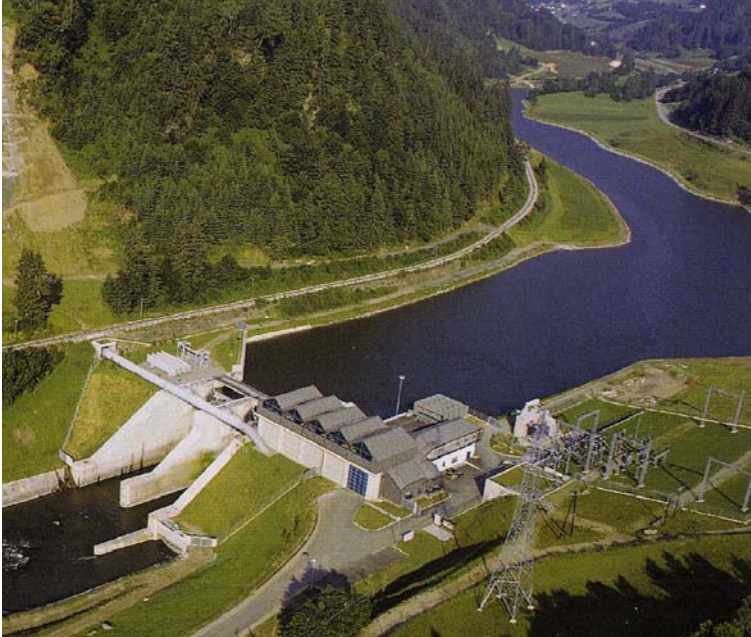
Abbildung 5: Das Kraftwerk Bodendorf
