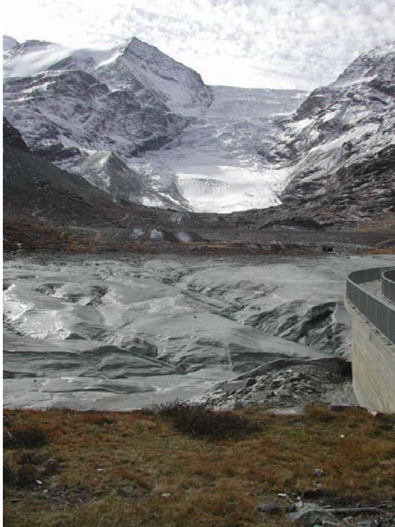
Abbildung 8: Teilweise verlandeten Speicher von Tourtemagne mit Gletscher im Hintergrund
