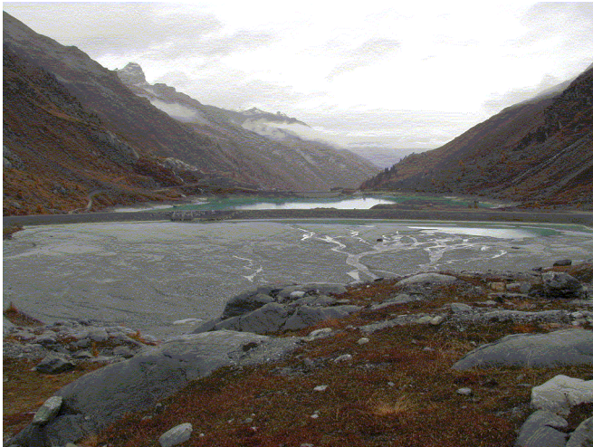
Vue amont du bassin de décantation et du barrage
