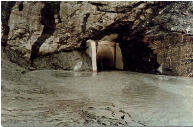
Abbildung 3: Sedimente vor Grundablass des Stausees Mauvoisin während der Entleerung im Mai 1985
