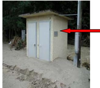
Figure 2 : Niveau de la crue 402.39 m pour un débit de 155 m<sup>3</sup>/s
