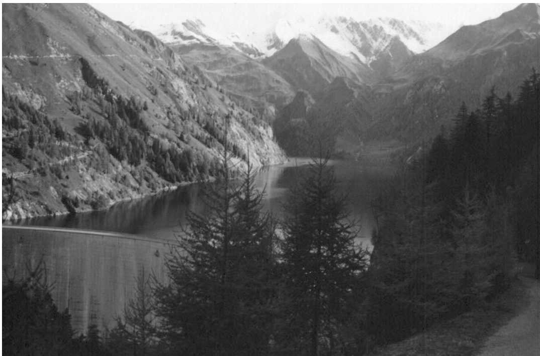
Figure 1.4 : Photo du barrage et de la retenue de Luzzzone
