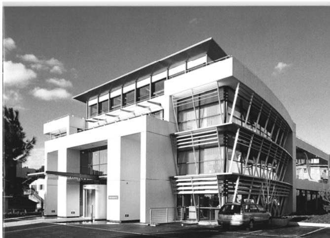
Figure 40. Bâtiment administratif Nespresso, Paudex
