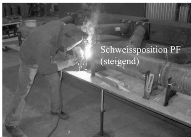
**Fig. 3.4:** *Schweissen des Probekörpers*
