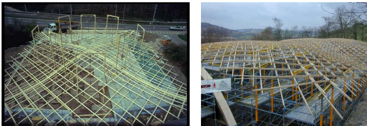
Abbildung 5: Montage des Polydôme auf dem Campus der ETH in Lausanne (links); Downland Gridshell, Chichester (GB) (rechts)
