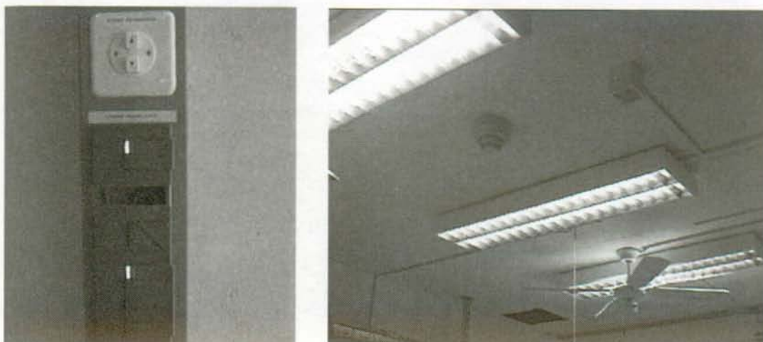
Figure 6 - 3: à gauche: Interface utilisateur pour la commande manuelle de l'éclairage artificiel et des stores.; à droite: luminaires et sonde de présence (en haut à droite).
