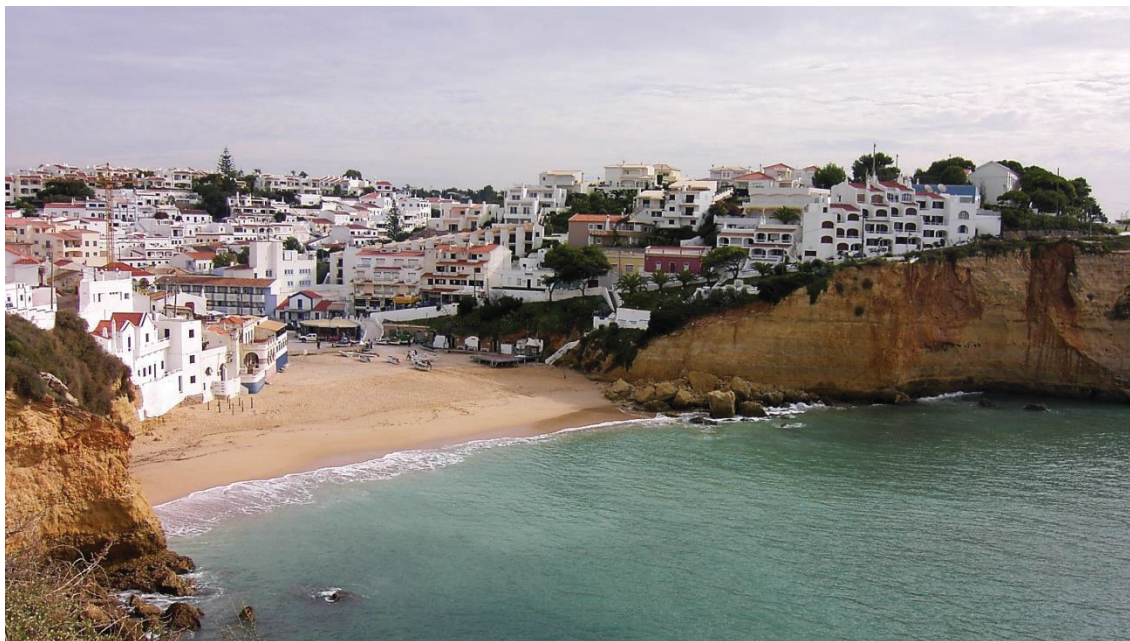
Figura 3 – Edificação em zonas de elevado risco: Praia do Carvoeiro, Algarve, Portugal, 2003; um exemplo da ocupação desregada que tem sido levada a efeito nas zonas costeiras (Foto: L.C. Fonseca).
