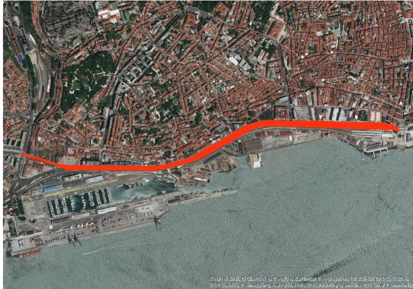
Figura 3.42. Avenida Vinte e Quatro de Julho
