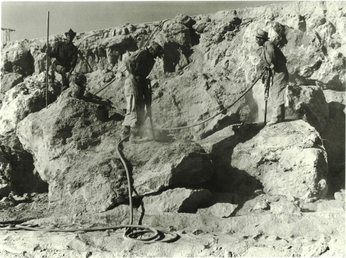
Perforación de bolones
