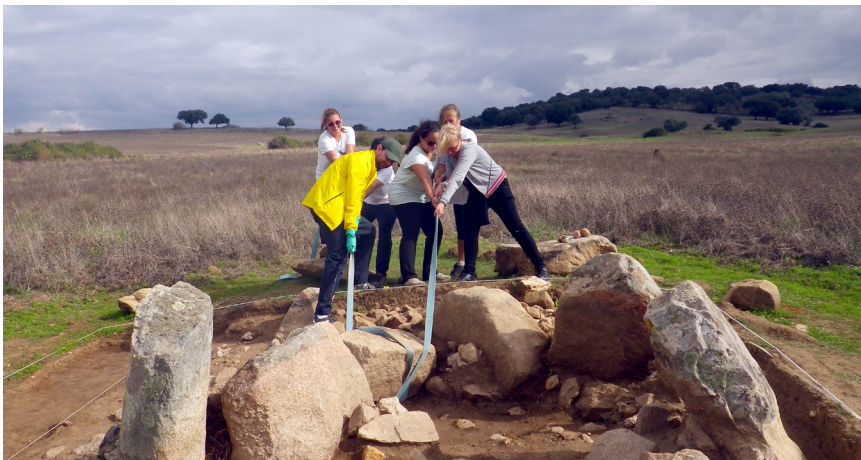
Figura 2 - Trabalhos finais de restauro
