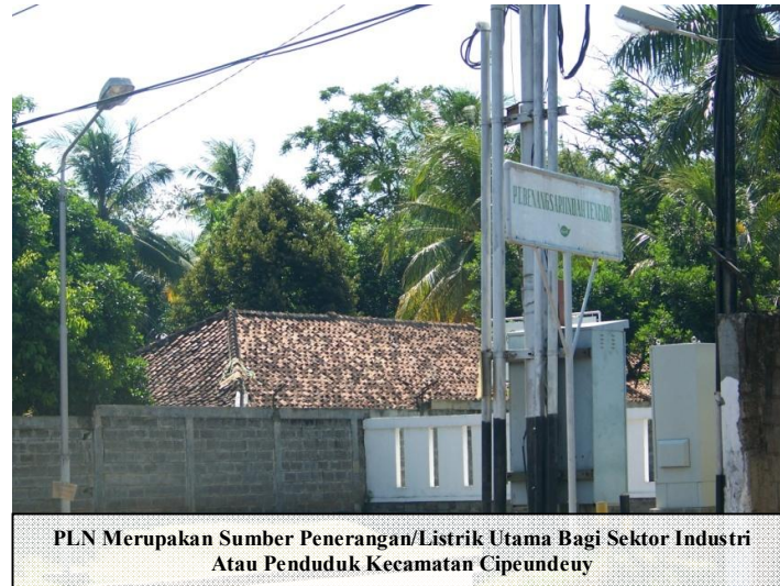
Gambar 3.12 Kondisi Sumber Penerangan/Listrik Di Kecamatan Cipeundeuy
