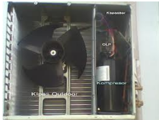
Gambar 4.2 Bagian dalam AC outdoor
