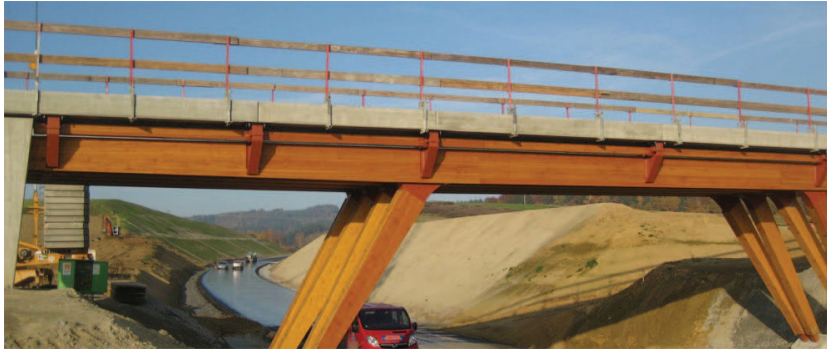
Abbildung 1.2: Holzstraßenbrücke Schwarzach - Hengersberg über die B533 (Foto © Schaffitzel + Miebach Faszination Brücken GmbH)
