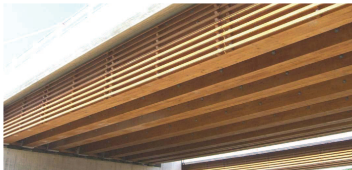
Abbildung 2.9: Unteransicht der Brücke Planchy bei Bulle (CH) [38]
