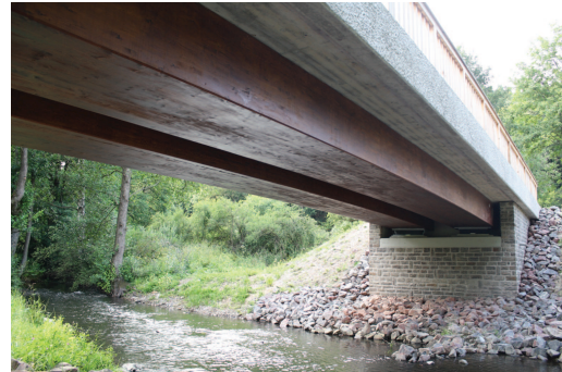
(b) Unteransicht der Brücke
