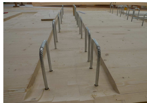
(b) Kerfen mit eingeklebten Bügeln
