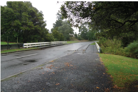
(a) Straßenansicht der Brücke
