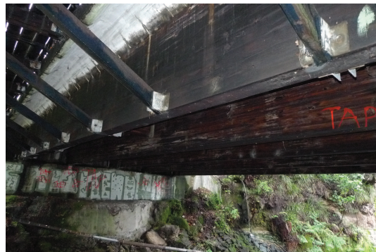
(b) Seitenansicht der Brücke
