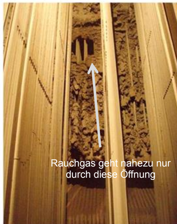
Abbildung A 2: Steinkohlegefeuertes australisches Kraftwerk mit massiven Ablagerungen im Bereich des Querzuges.
