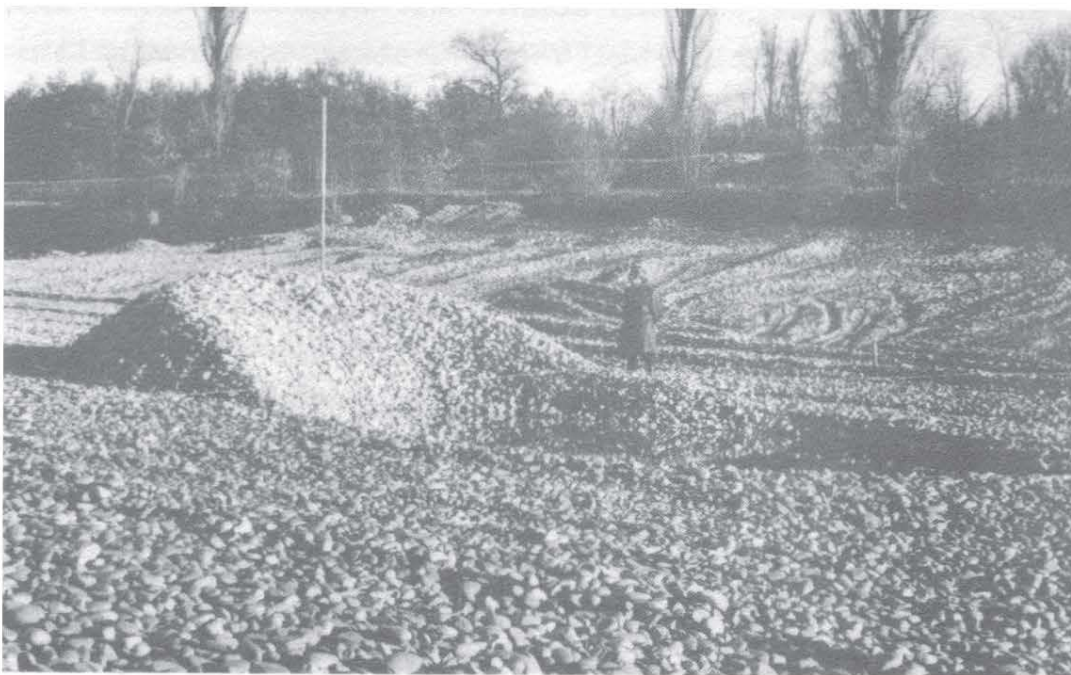
Bild 3 Erosion durch einen Schiffsantriebsstrahl in Natur nach [17]
