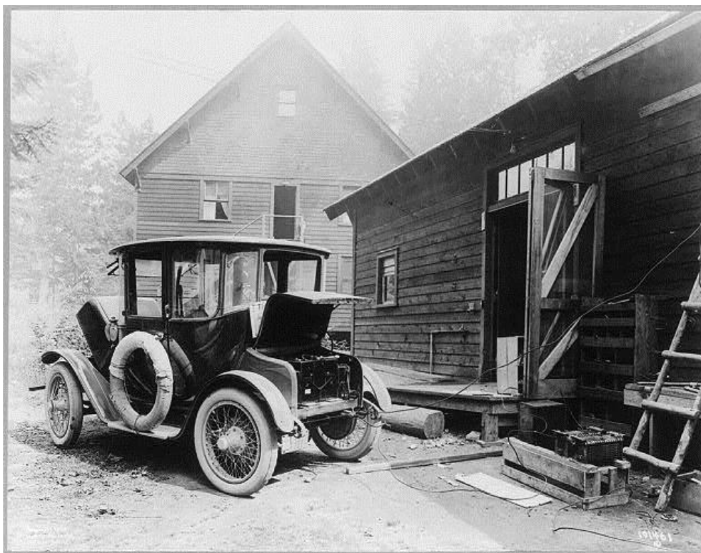
Abbildung 2: Frühes Elektromobil (um 1918) beim Aufladen der Batterie 2
