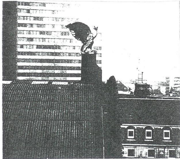
Abb. 37: Frankfurt/Main: Hauptbahnhof. Adler am Scheitelpunkt des nördlichen Perronhallendaches.
