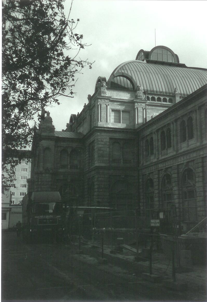
Abb. 176: Nürnberg: Hauptbahnhof. Von Carl Ritter von Zenger, 1900-1906.
