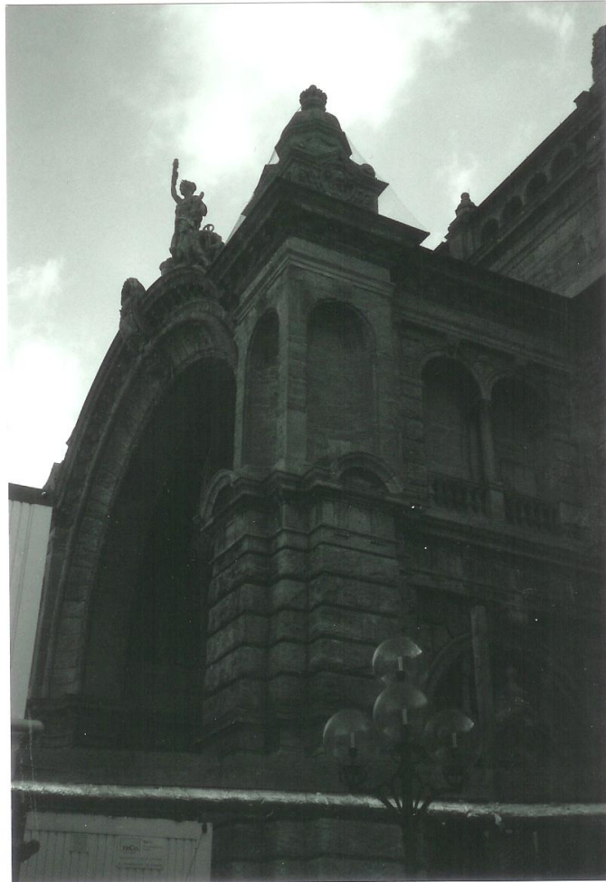
Abb. 177: Nürnberg: Hauptbahnhof. Von Carl Ritter von Zenger, 1900-1906.
