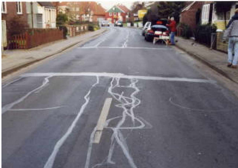
Abbildung 113: Örtliche Situation - Blick auf den Sanierungsabschnitt - im Hintergrund Einmündungsbereich in die Stader Straße
