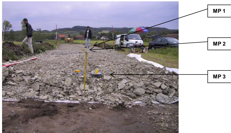
Abbildung 60: Prüffeld „geovliesbewehrte Tragschicht“
