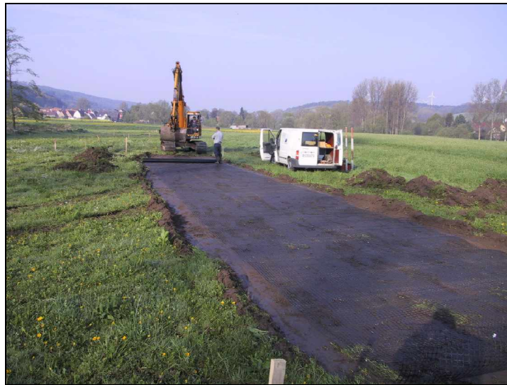
Abbildung 44: Beginn des Wegebaues, im Hintergrund der Ortsrand von Liebenau
