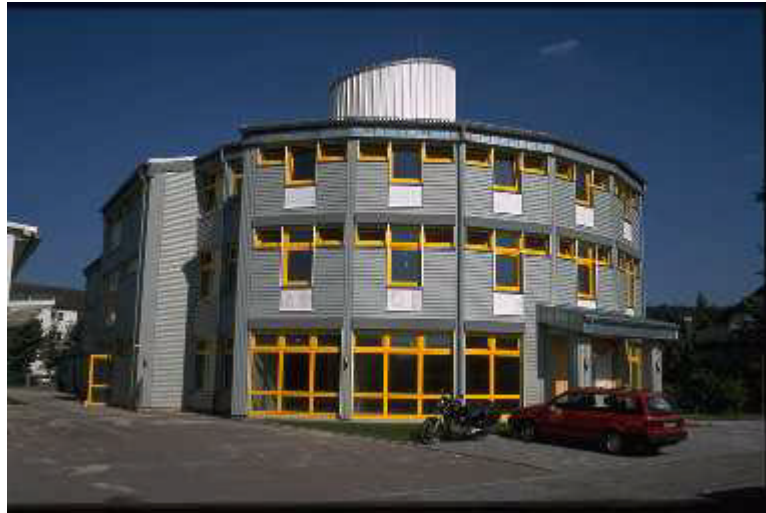
Abbildung 1.1: Das Passiv-Bürogebäude der Firma Wagner & Co Solartechnik. Das Bild zeigt die Ansicht von Westen, der in das Gebäude integrierte Saisonspeicher prägt maßgeblich das Gebäudedesign.
