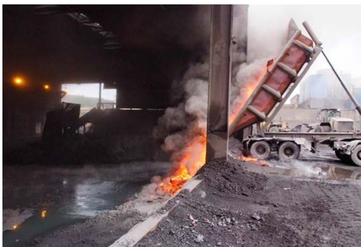
Figura 2.9. Vuelco del camión en la zona de enfriamiento.
