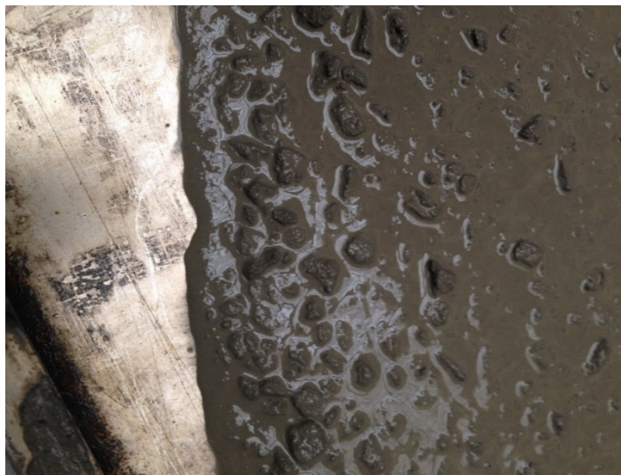
Figura 4.14. Aspecto del escurrimiento de la dosificación HAC-GOF-FE.
