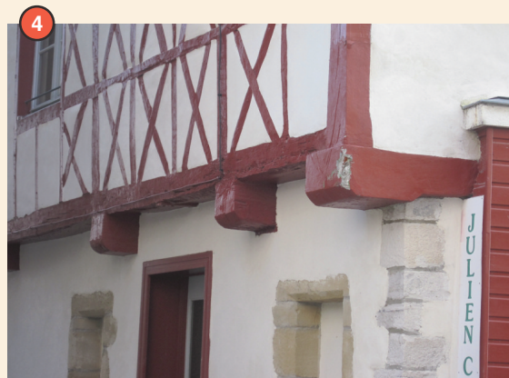
Rue Passemillon (construction à pans de bois et en encorbellement)
