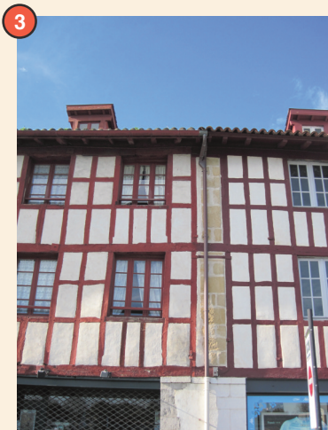
Quai A. Jaureguiberry (maisons à colombages avec mur mitoyen en pierre)
