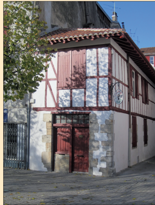
Maison basse rue Pelletier
