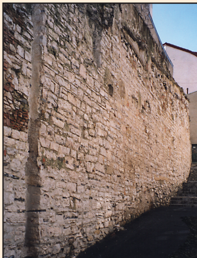
Mur entre la tour de la Pusterie et la Nive (parament vu de l'intérieur de la ville depuis l'angle de la rue des Basques)
