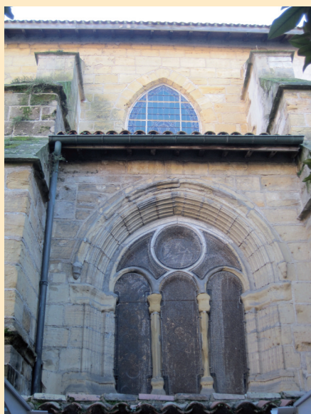
Latéral nord (détail des baies gothiques – bas-côté et nef)
