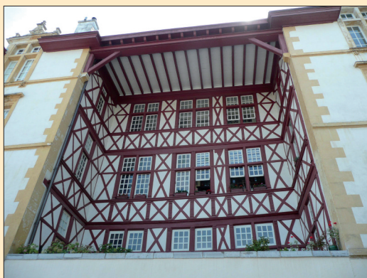
Façade rue Poissonnerie
