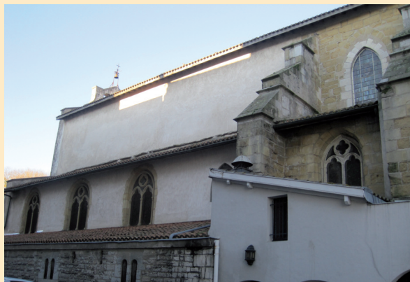
Latéral sud (bas-côté, nef et contreforts)
