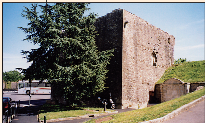
Tour de Sault (vue du côté nord)
