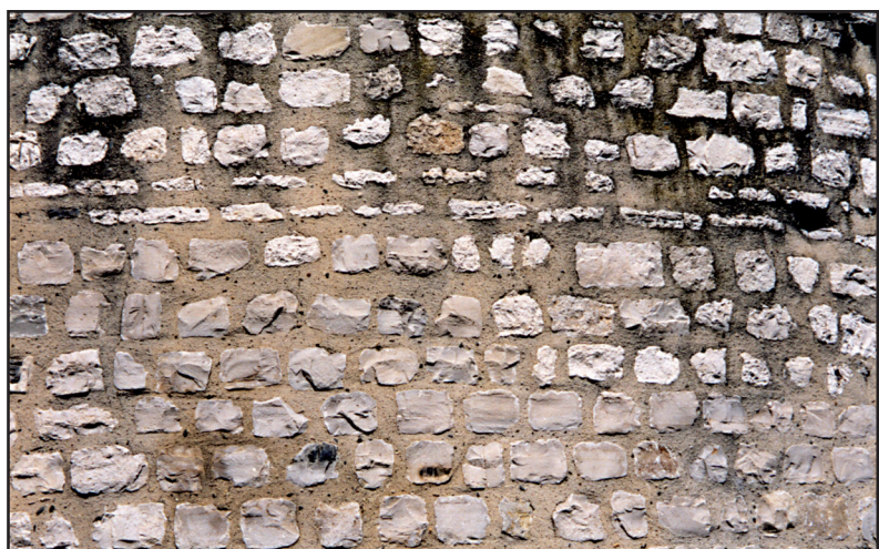
Technique d'appareillage antique ( opus regulare quadratum )
