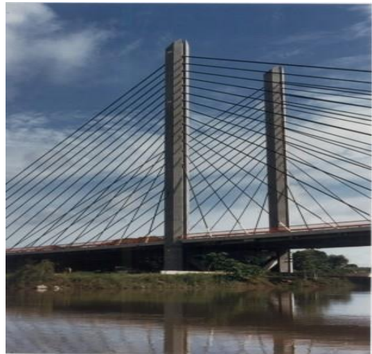
Figura 1. Puente atirantado donde se obtuvo el anclaje.
