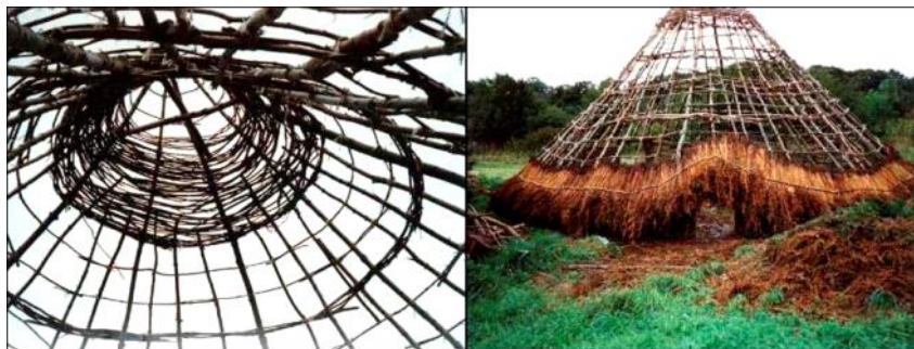
Fig.73: Distintas fases de la construcción de la cubierta vegetal de una réplica de una cabaña de la II Edad del Hierro en el Valle de Glamorgan (Gales del Sur). En la imagen de la izquierda se puede observar la estructura sobre la que se sustentará la paja que formará la cubierta. Llama la atención el entramado que se ha realizado, similar al encestado de las paredes pero más abierto. En la imagen de la derecha se puede apreciar la primera hilada de haces de paja colocada sobre el entramado, a la que le seguirán otras hiladas que se superpondrán hasta completar la cubierta. (Página Web de The Roundhouse Project ).
