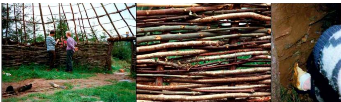
Fig.72: Tres imágenes del proceso de construcción de la pared de una réplica de una cabaña de la II Edad del Hierro en el valle de Glamorgan (Gales del Sur). Se aprecia la construcción del encestado de ramas y su posterior cubrición con capas de barro aplicadas sin emplear ningún tipo de instrumento específico. (Página Web de The Roundhouse Project ).
