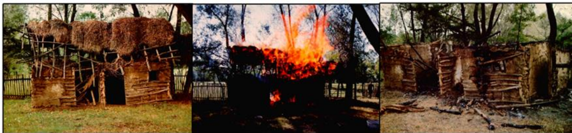
Fig.75: Fases del incendio deliberado realizado en 1978 por Bankoff. Puede apreciarse el incendio en su momento de mayor intensidad y el resultado final tras unas treinta horas de incendio, con las paredes de la vivienda aún en pie y el entramado apenas afectado. (Bankoff y Winter, 1979).
