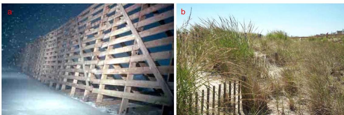
**Figura 22. Ejemplos de barreras constituidas por madera: (a) Pantalla antivientisca tipo Wyoming (Tablet y Meena, 2007) y (b) Barrera para controlar el proceso de formación de dunas (Grafals-Soto, 2012).**
