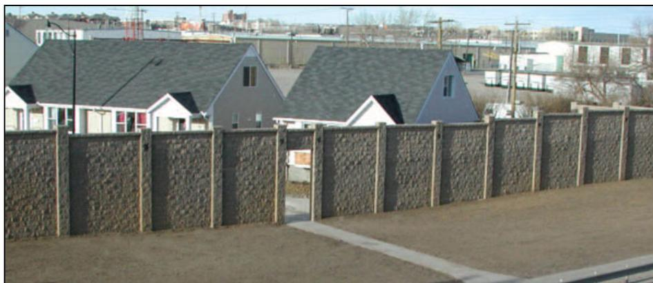
Figura 25. Muros de hormigón para proteger viviendas del ruido generado en las vías de transporte (<http://www.allanblock.com>).
