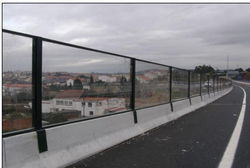
**Figura 19. Ejemplo de pantalla acústica instalada en una carretera próxima a una zona urbana** (<http://www.insonor.com/servicios-aislamientos-acusticos/insonorizacion-acustica-industrial/pantallas-acusticas>).
