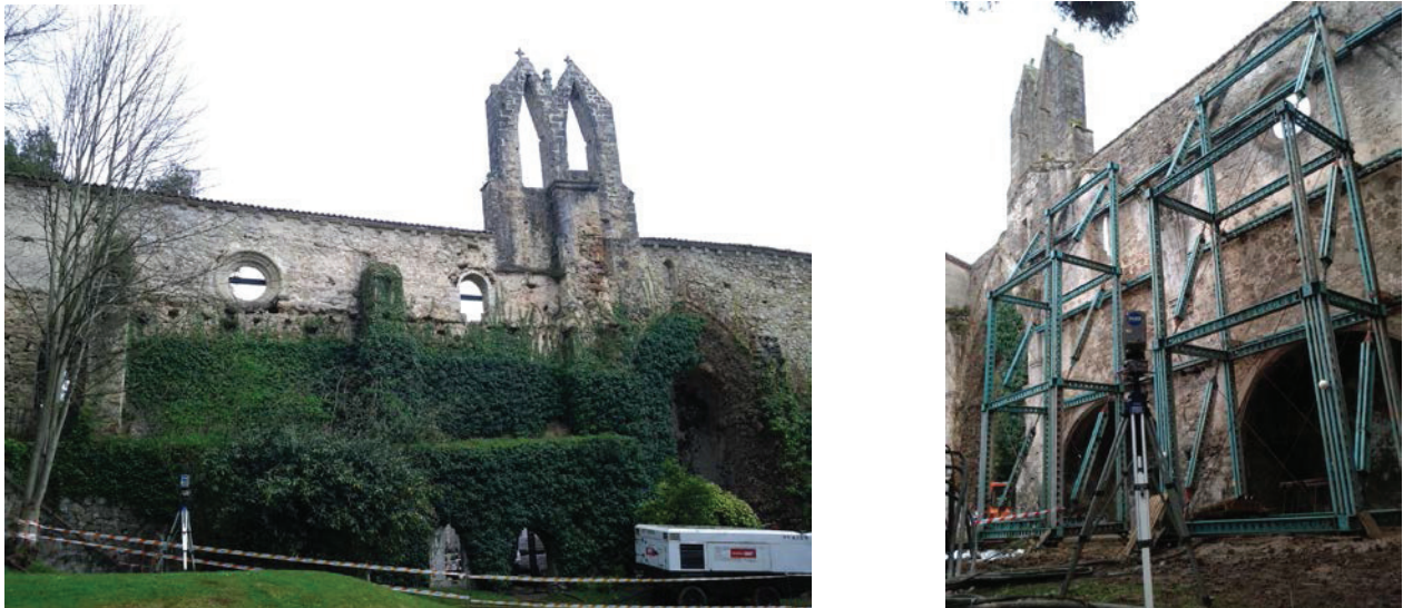
Figura 1: Fachada del convento de San Luis y estabilizadores.
