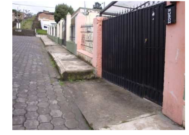
Adaptación de acera para la entrada a garaje
