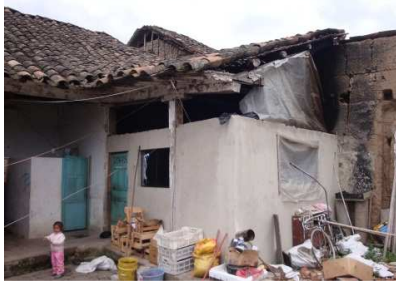
Desorden y desperdicios en el interior de la vivienda
