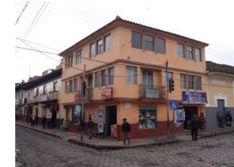
Tipología de bloque en esquina de Bolívar con Colón
