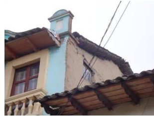
Vivienda recrecida: detalle de los materiales
