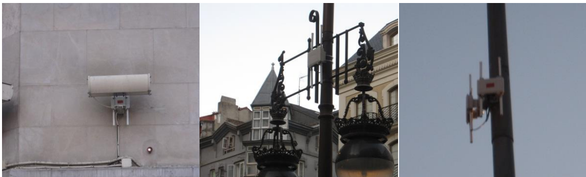
Figura 3.9. Instalación de pasarelas en farolas y fachadas
