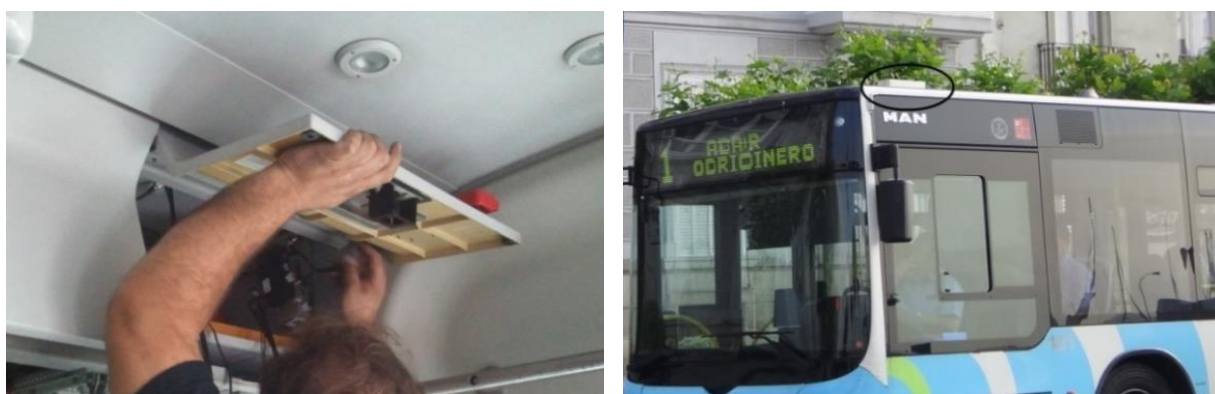
Figura 3.14. Instalación en autobuses en el interior (izquierda) y exterior (derecha)
